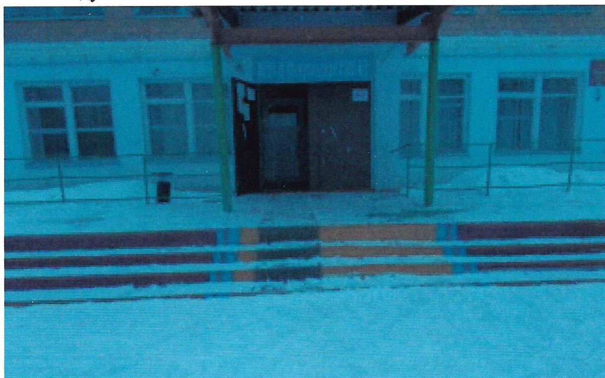
ФОТО №14. Наружная лестница.
