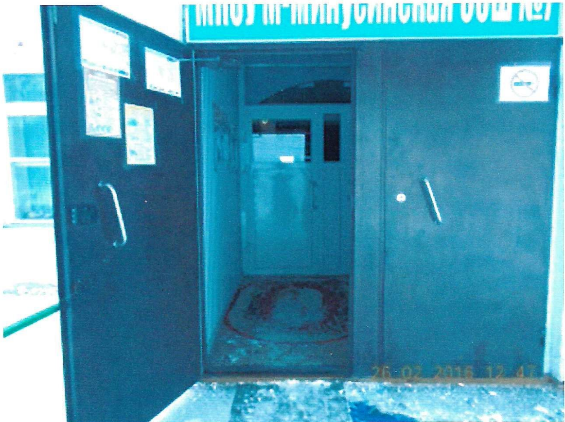
ФОТО №2 Вход в здание школы.
